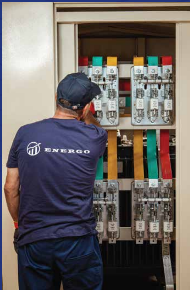
Yeni KTM-də 0.4 kV qoruyucuların montajı
