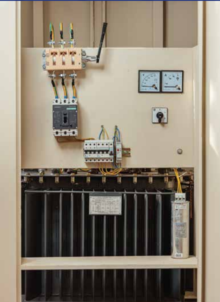
KTM-in 0, 4 və 10 kV-luq tərəfləri montajdan sonra
