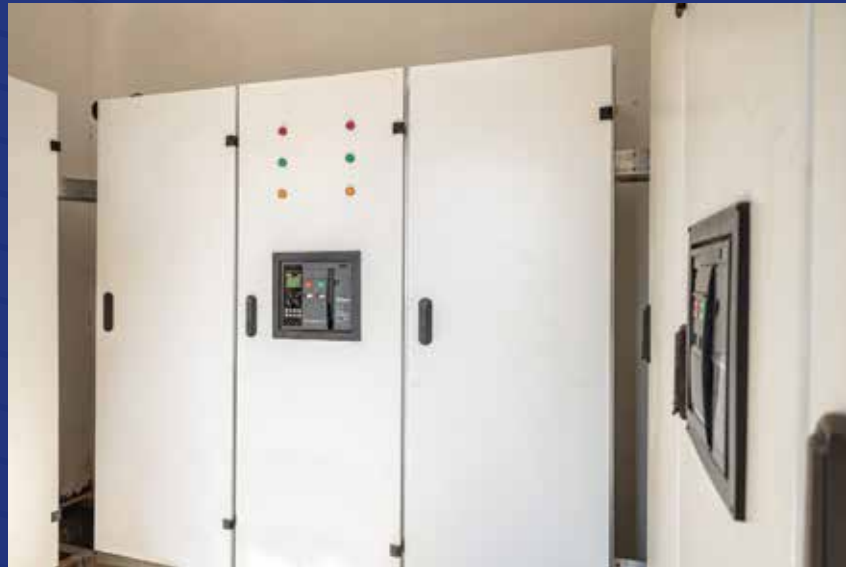
Yeni tikilmiş transformator məntəqəsində quraşdırılan 0.4 kV-luq baş və çıxış panelləri
