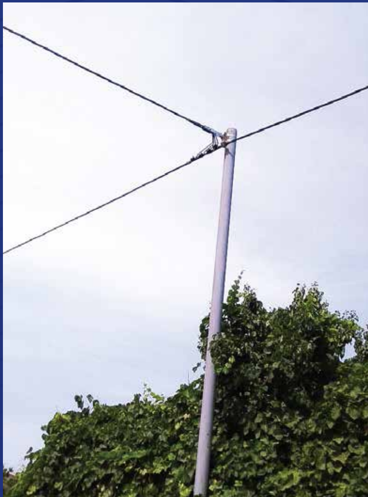
0.4kV-luq ÖİN xətlərin çəkilişi Xaçmaz rayonu, Muxtadır qəsəbəsi
