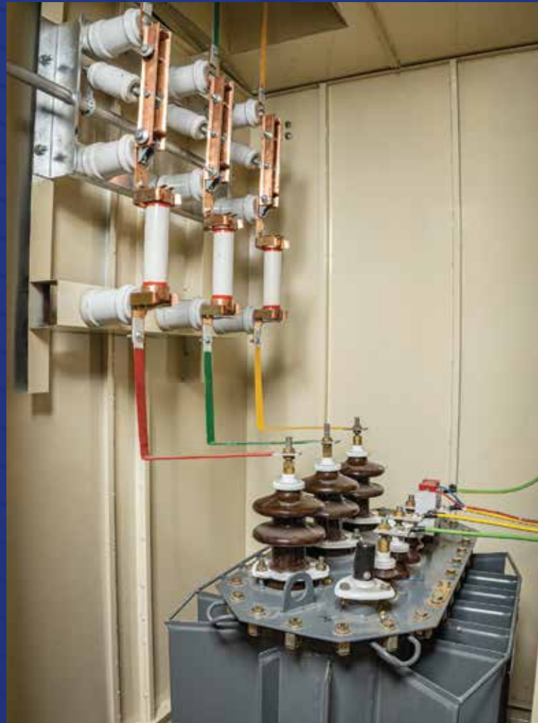
KTM-in 0, 4 və 10 kV-luq tərəfləri montajdan sonra
