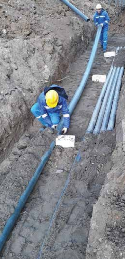
0.4 kV-luq kabel xətlərinin çəkilməsi üçün PVC boruların montajı
