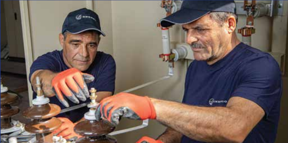
Komplekt transformator məntəqəsində transformatorun montajı
