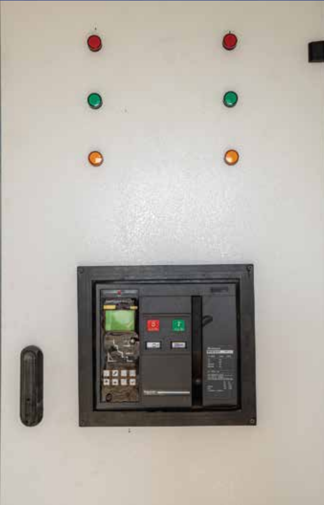
Yeni tikilmiş transformator məntəqəsində quraşdırılan 0.4 kV-luq baş və çıxış panelləri
